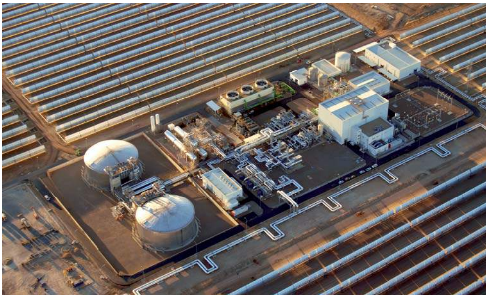
Figura 8. Bloque de potencia y sistema de almacenamiento de la Central La Florida en Badajoz. Propiedad de Renovables SAMCA.
